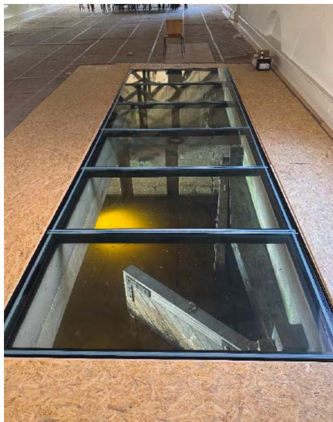
En af de sidste opgaver i ombygningen var at lægge solide glasplader i gulvet i Maskinhallen, så gæsterne kan kigge ned til vandet, der strømmer gennem sluserne under bygningen.
